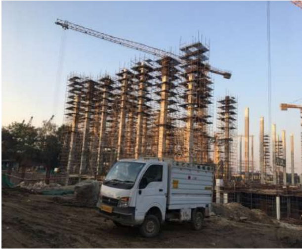
चित्र:10 निर्माणाधीन प्रगति मैदान Fig:10 Pragati Maidan- under construction
